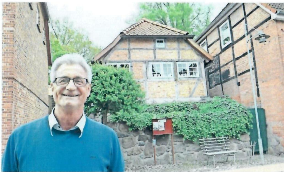
Die Altenteilerkate muss saniert werden. Der Vorsitzende Hans Espenschied ist zuversichtlich, dass der Verein die Herausforderung in schwieriger Zeit meistern wird.
